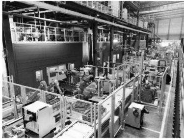
图1 联体缸盖智能化组芯线
