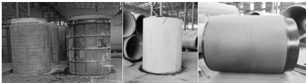
图12 整铸短顶管砼作业
