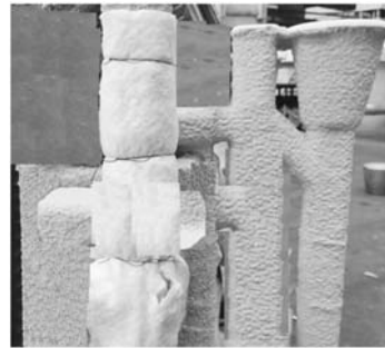
图6 实际保温状态 Fig. 6 Actual heat preservation state
