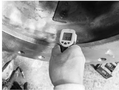
图7 385工程铸钢节点焊前预热
